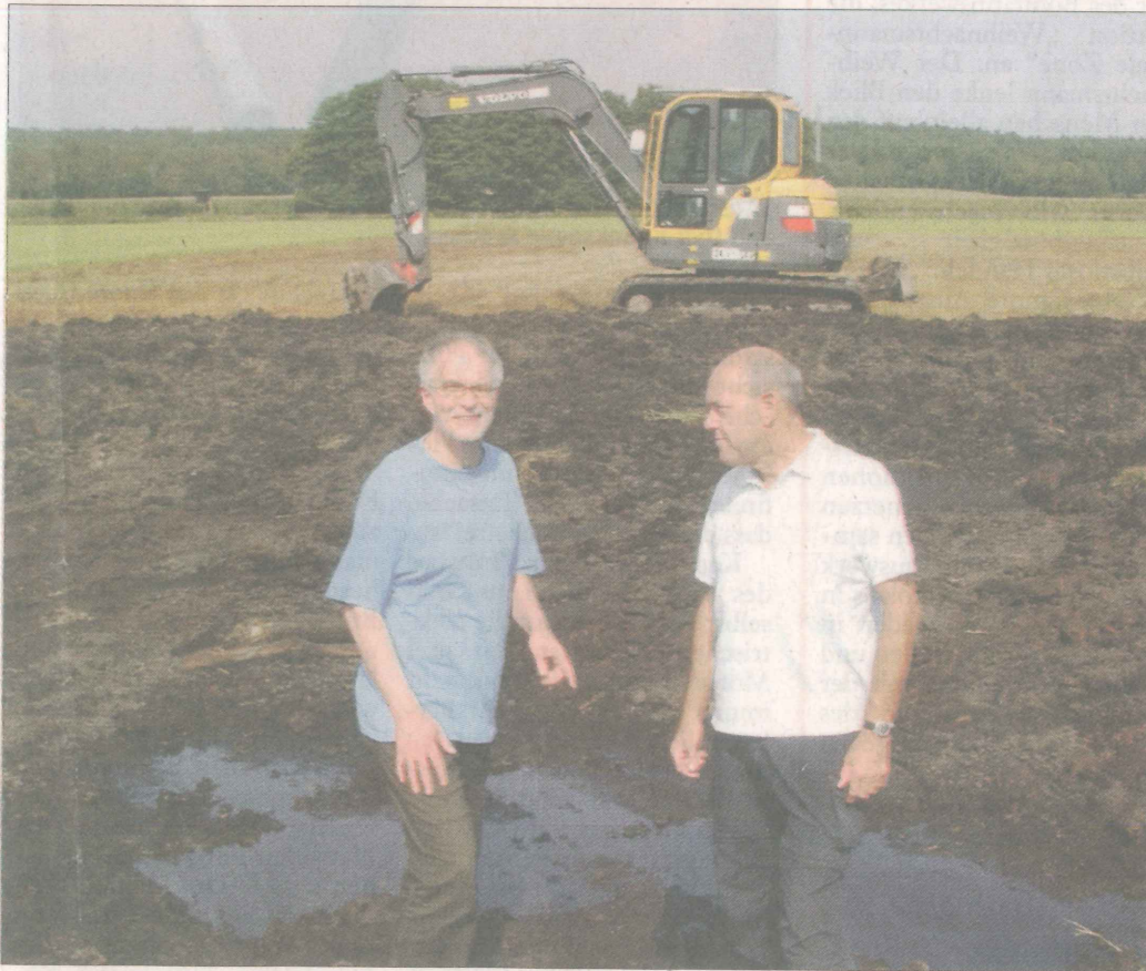
Nach den Baggerarbeiten für die Blänke untersuchen der Stiftungsbeauftragte der Stiftung Kulturlandpflege im Landkreis Nienburg, Harald Frerking (rechts), und der Eigentümer Fritz Beermann (links) den Boden auf die reichlich vorhandenen mumifizierten Erlenwurzeln. Foto: Privat
